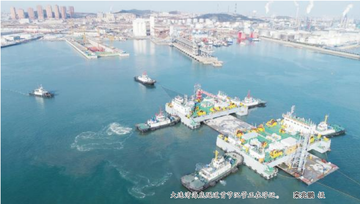
大连湾海底隧道首节沉管正在对接。 宋兆鹏 摄
