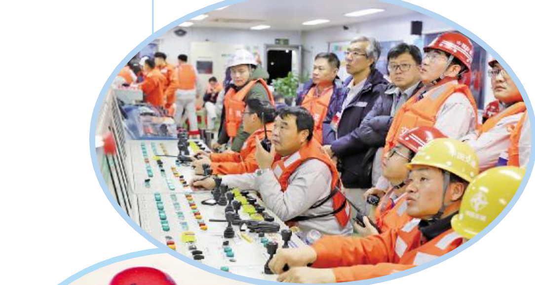
▲大连湾海底隧道首节沉管出运安装,“津安3”上的工作人员专注地控制管节沉放。 梁兆鹏 摄
