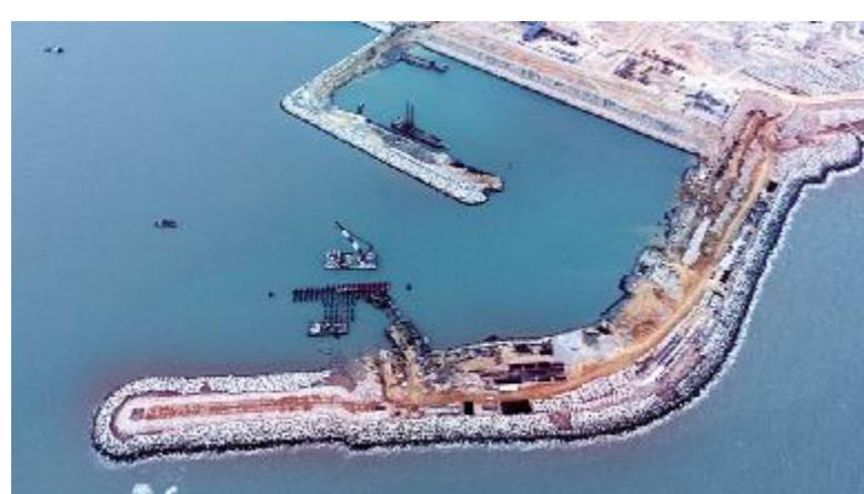
▶ 2017 年 4 月 15 日，长江西陵以下 12.5 米深水航道二期工程和畅洲标段 2 道长度分别为 1817 米和 1919 米的港堤及 5 段总长度为 12.265 公里的专项护岸工程主体全部完工。该标段较合同工期提前 11 个月全面完成主体施工任务，高效的履约、敢打敢拼的作风受到业主“王中之王”盛赞。
