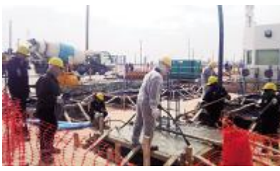
独立地基浇注作业 曹茂祥 摄
