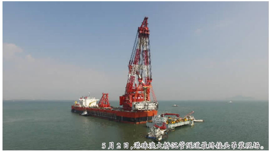
5月2日,港珠澳大桥沉管隧道最终接头吊装现场。
