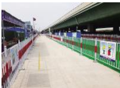
▲10月13日下午,青岛市市政标准化工地现场观摩会在建安分公司太原路工程现场举行。青岛市市政管理处、青岛市政投集团、施工、监理等70多家单位,共计170余人观摩。
