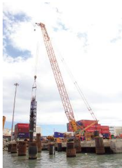
▲近日,公司的参建智利STI项目完成最后一根钢管桩的打设,钢管桩分项施工圆满完成。钢管桩施工历时309天,成功打设82根钢管桩。下一步,项目部将重点推进开挖、护坡以及上部结构的施工。
