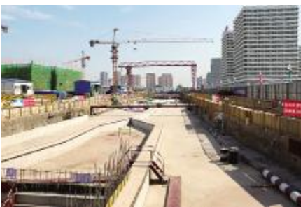
▲日前,由公司承建的青岛轨道交通13号线东方影都车站正式完成主体结构封顶。该车站为地下两层,12米岛式站台,车站主体长233.5米,车站顶板埋深3.0-3.8米,地下两层基坑深度约为18.91-17.11米,采用明挖顺作的方法施工。
