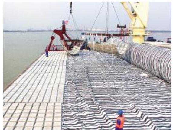
▲ 软体排铺设施工
