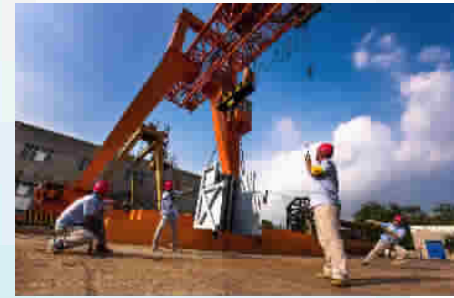
长江航道工程筹备现场
