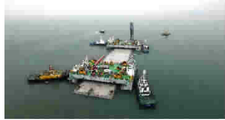
港珠澳项目部 E24 沉管安装现场
