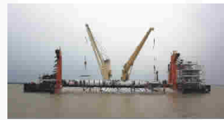
长江航道二期工程铺排现场
