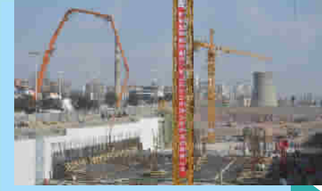
青岛地铁 13 号线施工现场
