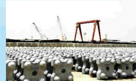
沙特海尔德四期工程现场
